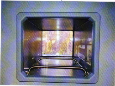
Für den Lichteinfall hat BMC einen ca. 30 cm tiefen Kubus mit Fenstern versehen.
